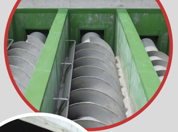
BKU II HDPE T-grip aangebracht in vijzelgoot
