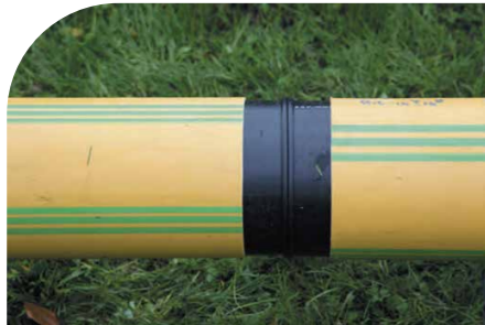
Verbroken beschermmantel na lassen
