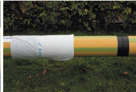
Krimpmantel wordt over las geschoven
