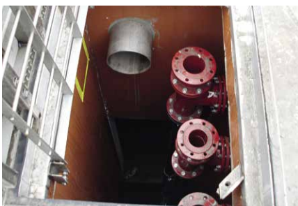
BKU I PVC T-grip in rioolgemaal
