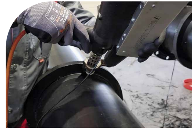
Extrusielassen, bijvoorbeeld leidingen voorzien van puddle flenzen
