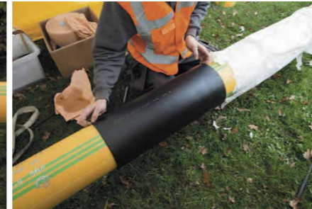
Verpakking krimpmantel wordt verwijderd
