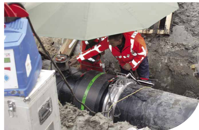
Aanbrengen PE-HD elektrolasmof dia. 800 mm
