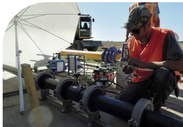
Aanbrengen PE-HD elektrolasmof dia. 125 mm vlg NTA 8828
