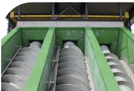
BKU II PE-HD T-grip aangebracht in vizelgoot
